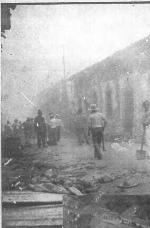
Vecinos trabajando en el escombros
