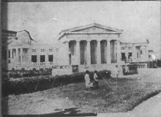
El Ayuntamiento de Managua, destruido por el terremoto
